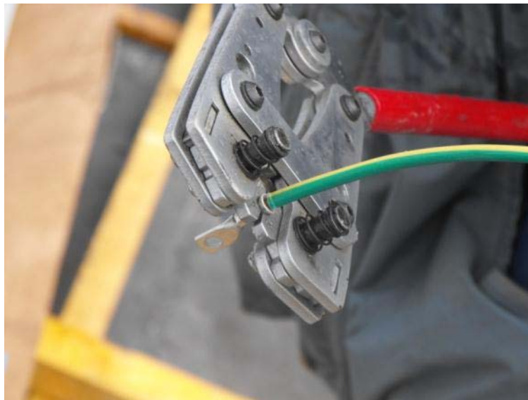
Figure 5 : Mise en œuvre de la cosse de mise à la terre par sertissage
