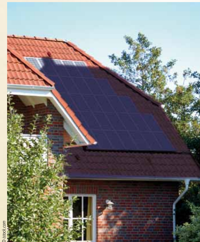
Installation de panneaux photovoltaïques dans l'ombre
